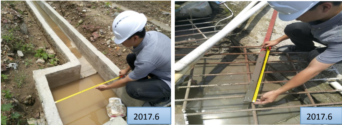
图 3-4 水土保持临时措施照片
